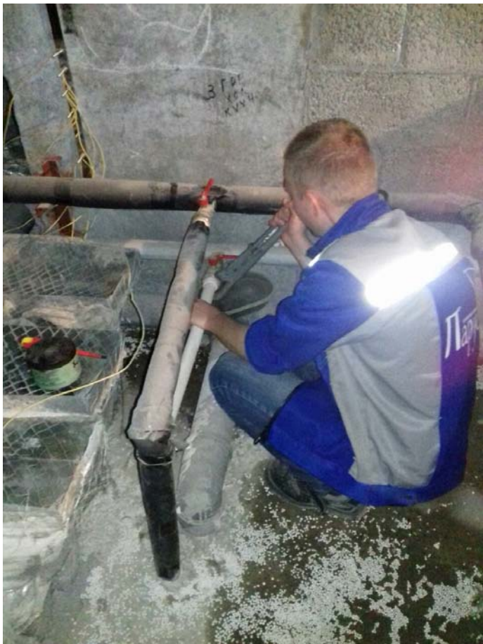
Ревизия шаровых кранов системы отопления и замена.
