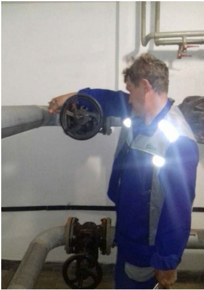
Протяжка сальников повысительной насосной станции.
