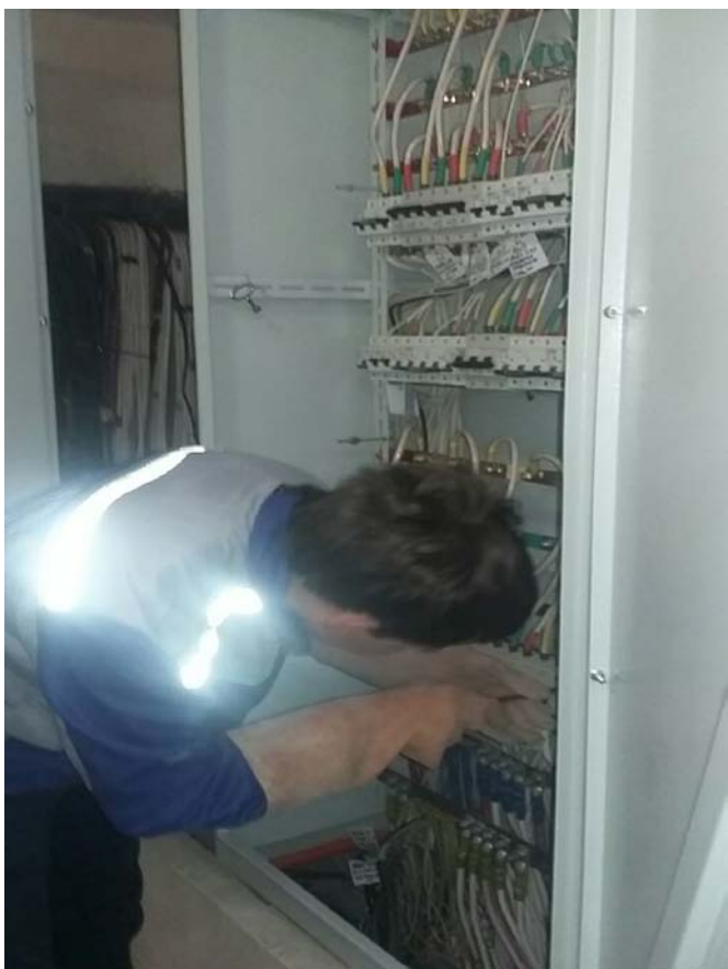
Протяжка автоматов в эл. щитовой.
