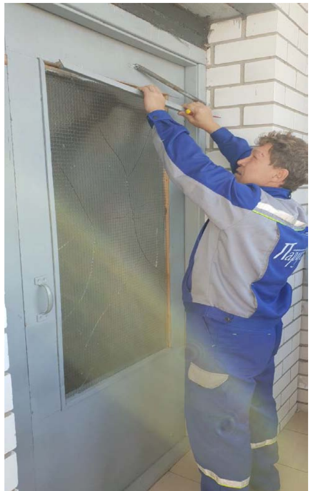
Ремонт дверей переходных балконов.
