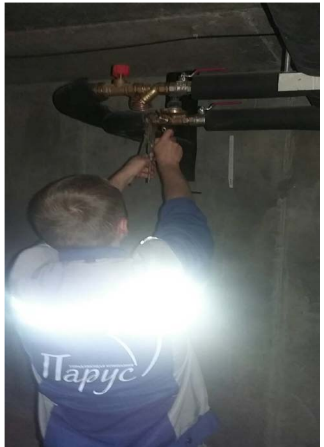
Ревизия запорной арматуры.
