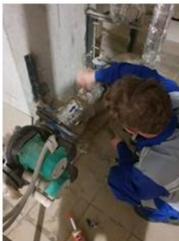
Замена неисправных трехходовых кранов и манометров
