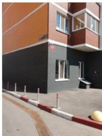
Установка таблички с обозначением места установки специальной техники
