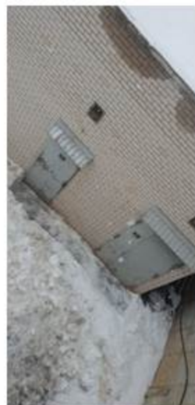
Расчищен вход на ТП-3
