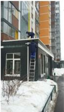
Прочистка ливневок входных групп
