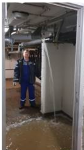
Устранение засора канализации
