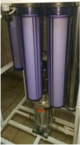
Заменены фильтры в системе 3 кран
