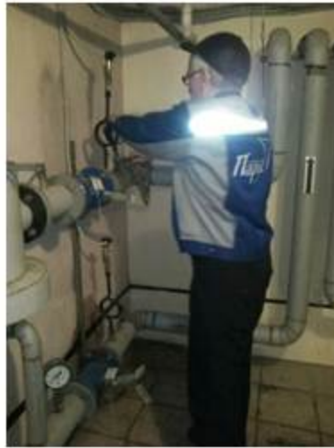
Замена трех ходового крана
