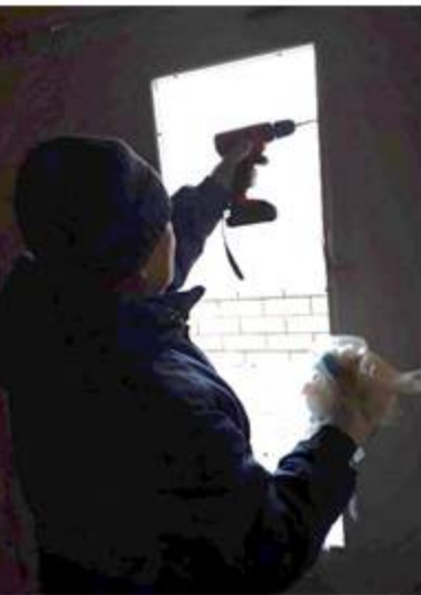
Замена разбитого стекла .6 этаж
