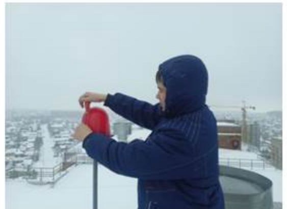
Замена ламп на сигнальных фонарях
