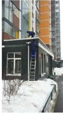
Прочистка ливневок входных групп
