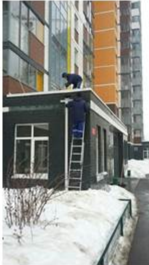
Прочистка ливневок входных групп
