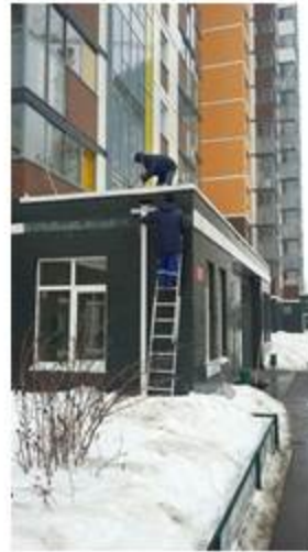
Прочистка ливневок входных групп
