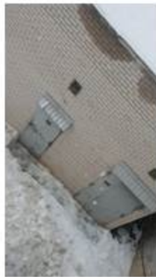
Расчищен вход на ТП-3
