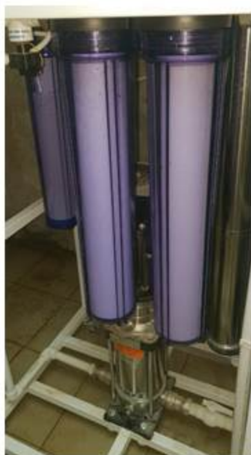
Заменены фильтры в системе 3 кран
