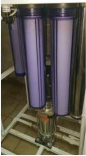
Заменены фильтры в системе 3 кран
