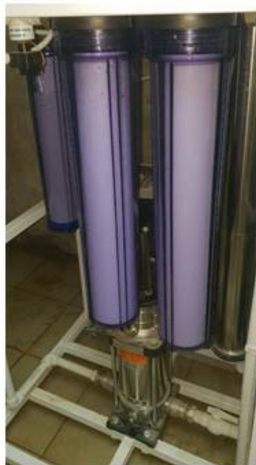
Заменены фильтры в системе 3 кран
