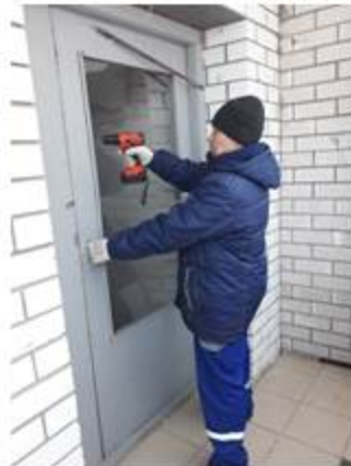
Замена разбитого стекла. 5 этаж
