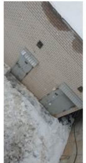
Расчищен вход на ТП-3
