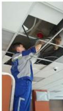
Замена полупровода на общедомовом стояке канализации.
