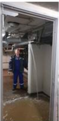
Устранение засора канализации
