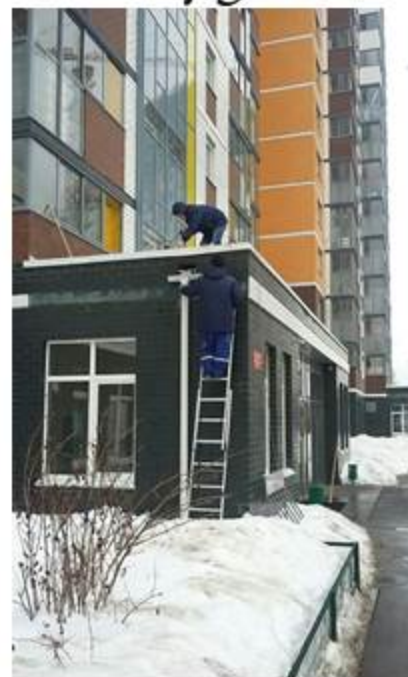
Прочистка ливневок входных групп
