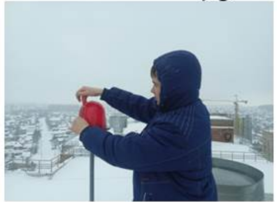
Замена ламп на сигнальных фонарях
