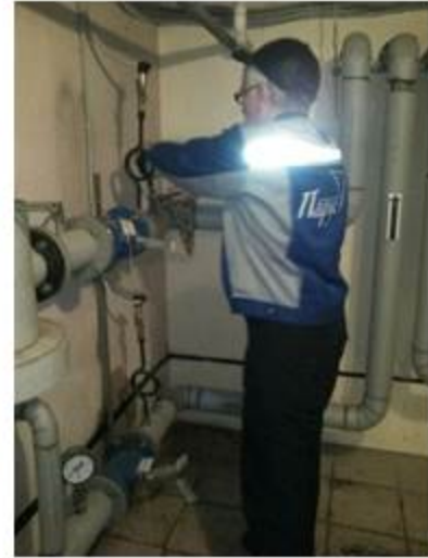
Замена трех ходового крана
