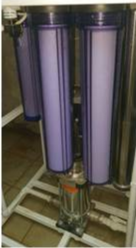
Заменены фильтры в системе 3 кран
