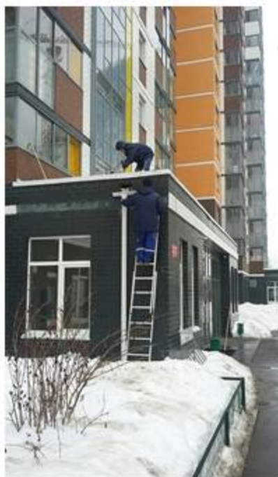
Прочистка ливневок входных групп
