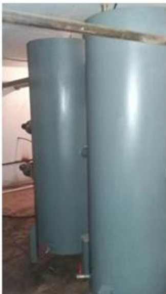
Поставили промежуточные емкости. Пропали стуки
