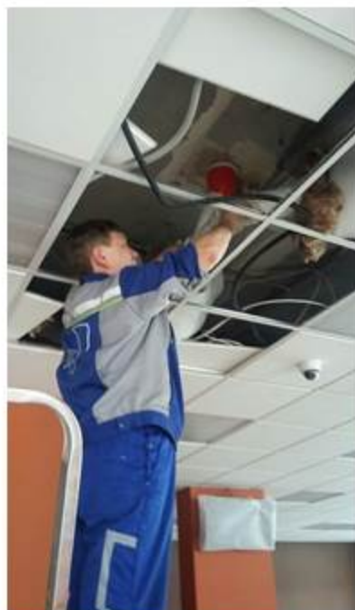
Замена полупровода на общедомовом стояке канализации.
