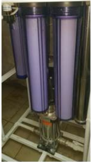
Заменены фильтры в системе 3 кран
