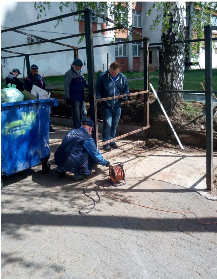
Перенос контейнерной площадки.
