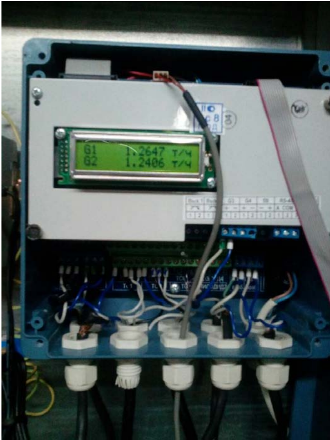
Ремонт, проверка и сдача узла учета ТЭ.
