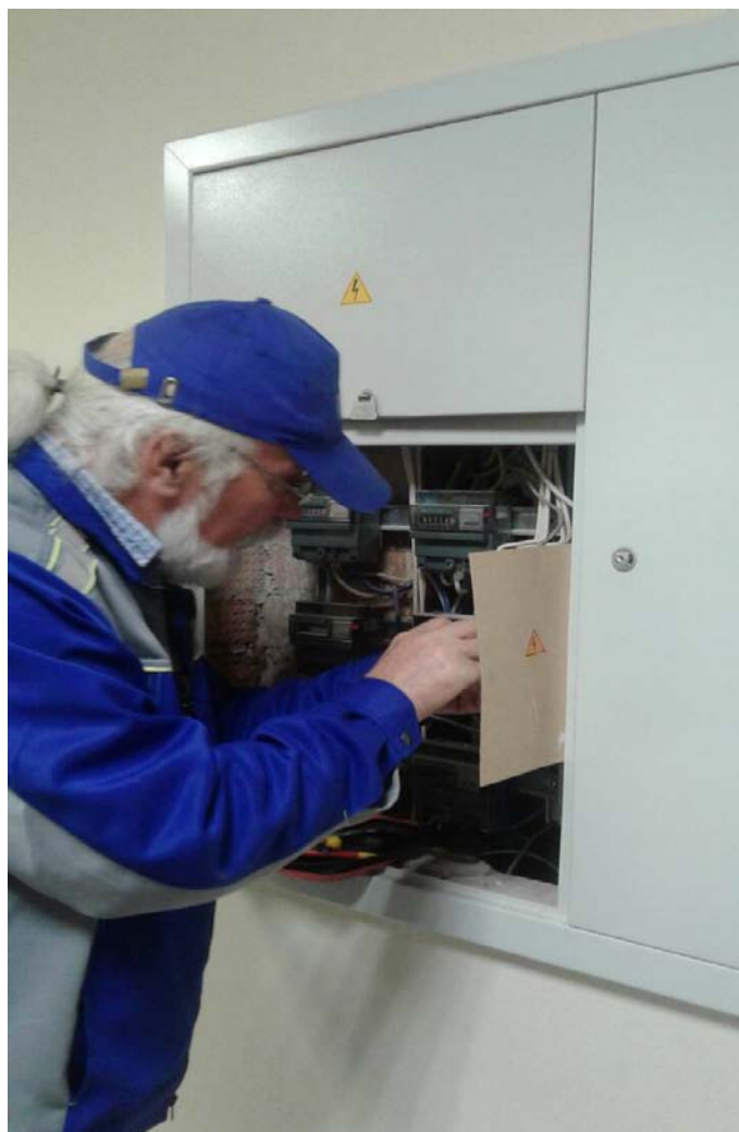
Протяжка контактов в поэтажных электрощитах.
