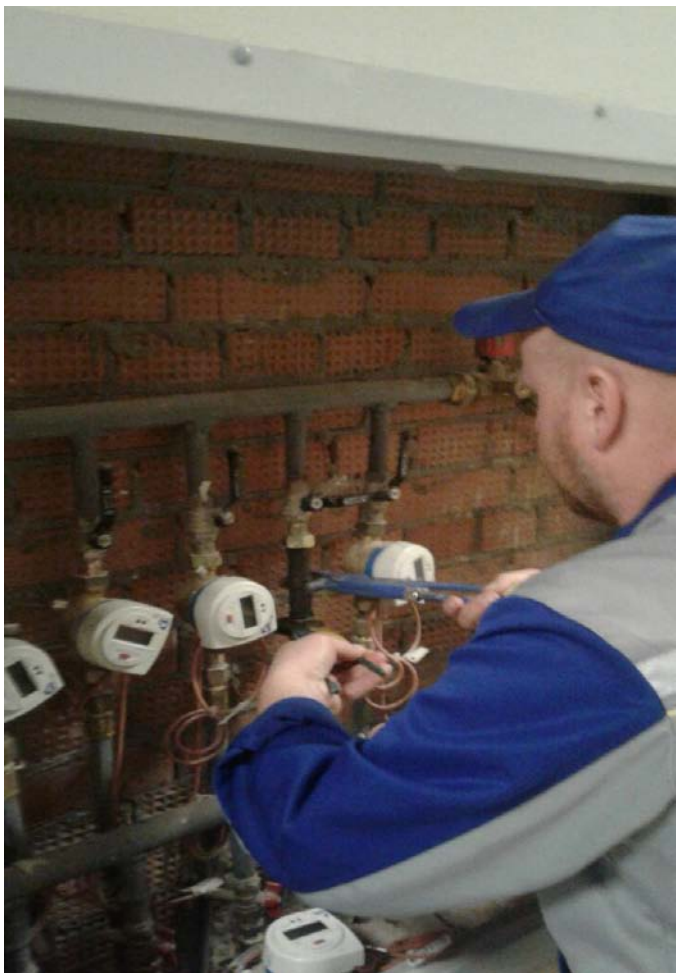
Ревизия резьбовых соединений системы отопления
