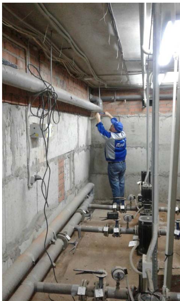
Ревизия запорной арматуры пожарных трубопроводов.
