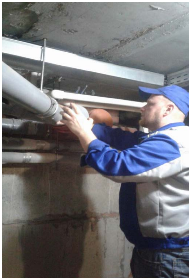
Профилактические работы на системе канализации
