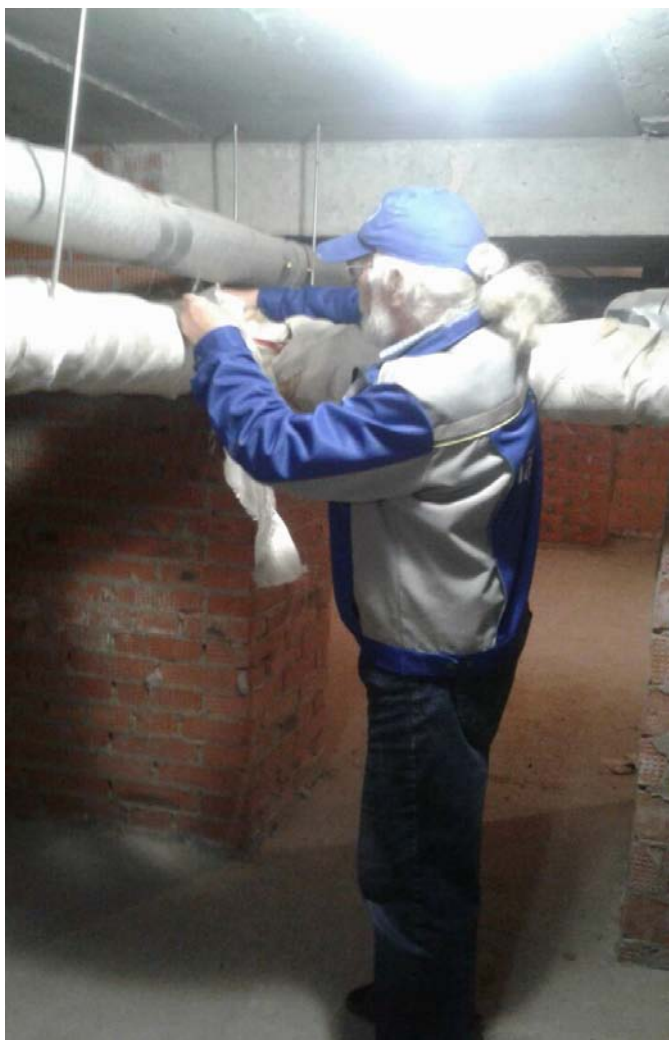
Укрепление теплоизоляции трубопроводов ГВС.
