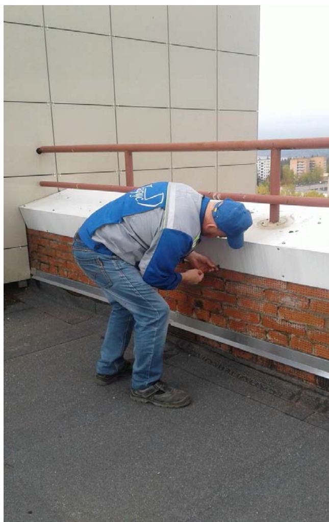
Укрепление парапетного козырька на кровле.
