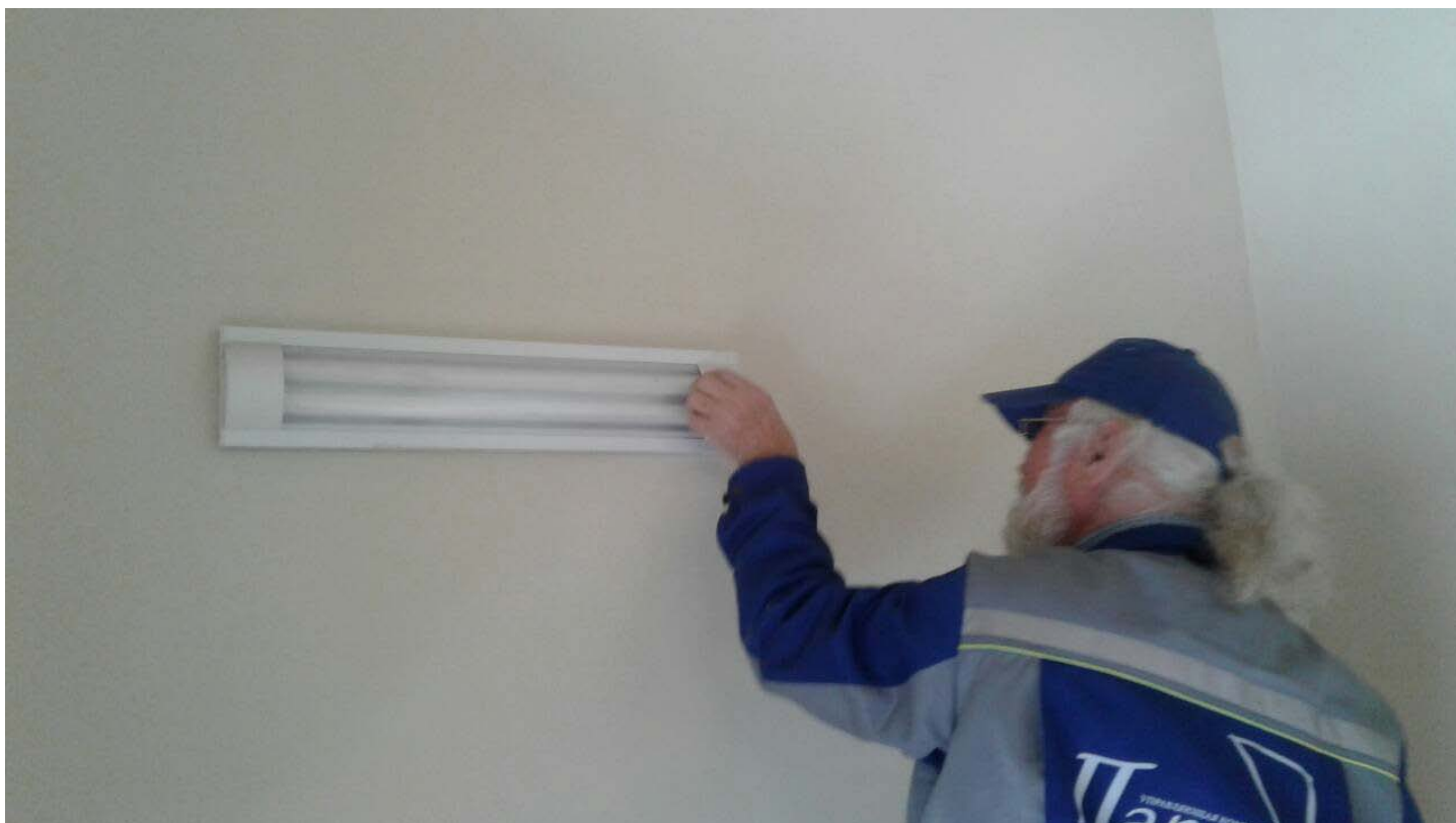
Замена ламп в светильниках лифтовых холлов, лестничных клетках и технических этажах.
