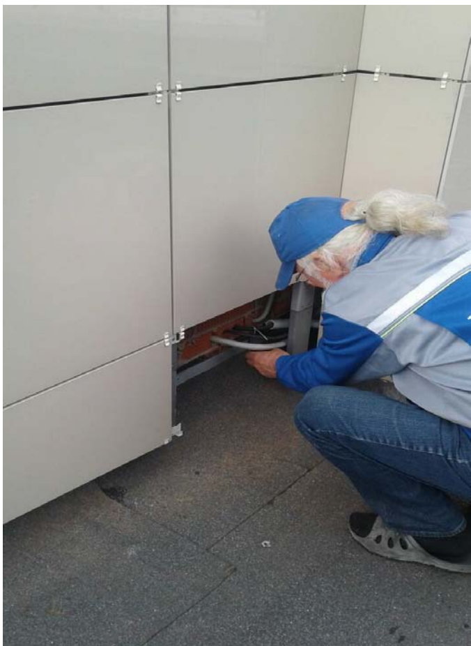
Устранение обрыва питающего кабеля клапана ДУ
