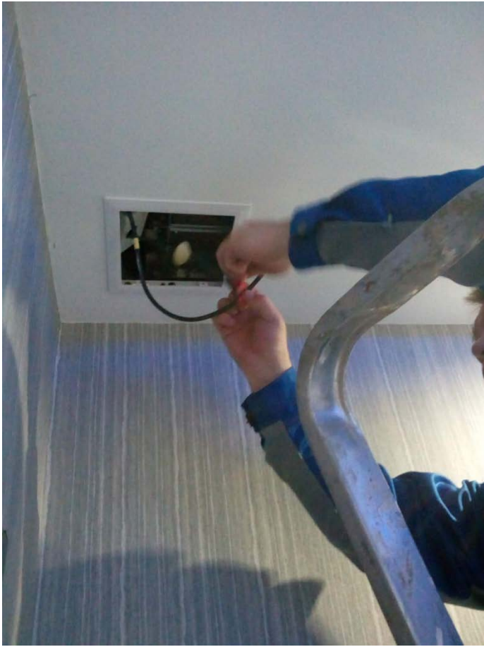
Ремонт противопожарных клапанов на системе вентиляции.
