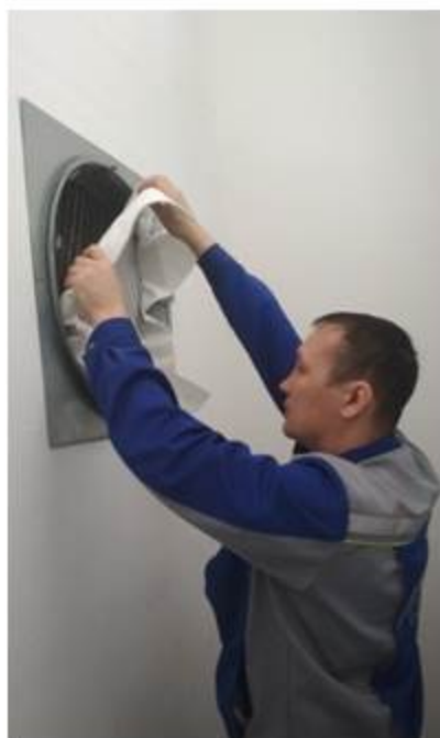
Замена предфильтров, приточных установок
