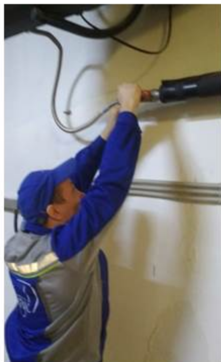
Ревизия заборной арматуры
