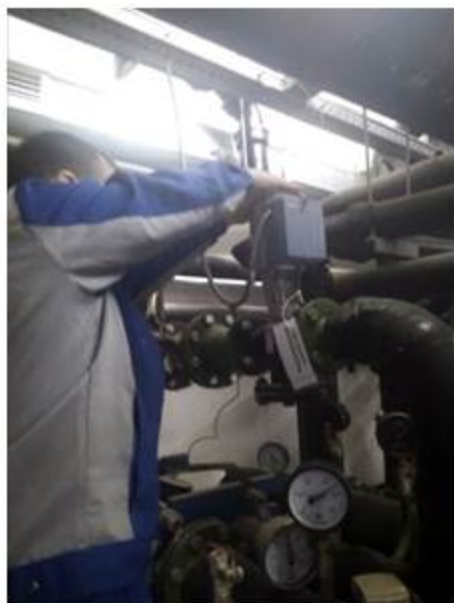
Регулировка клапана теплоносителя
