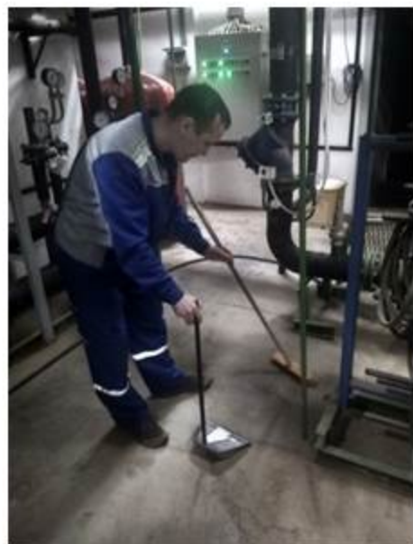
Уборка в технических помещениях
