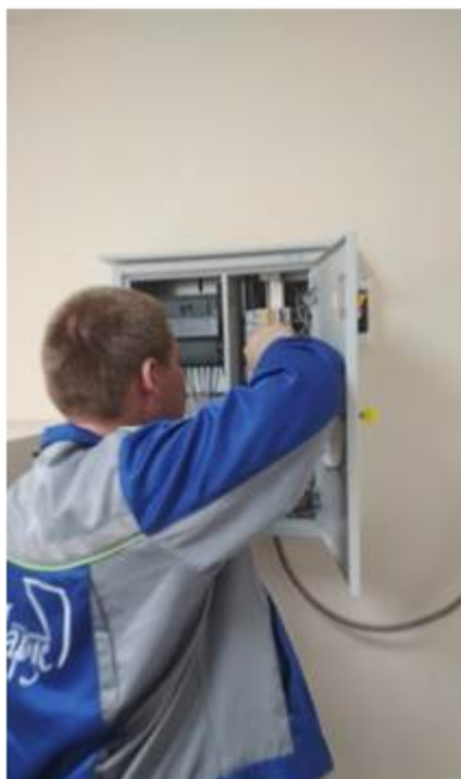
Замена автоматов в электрощитах
