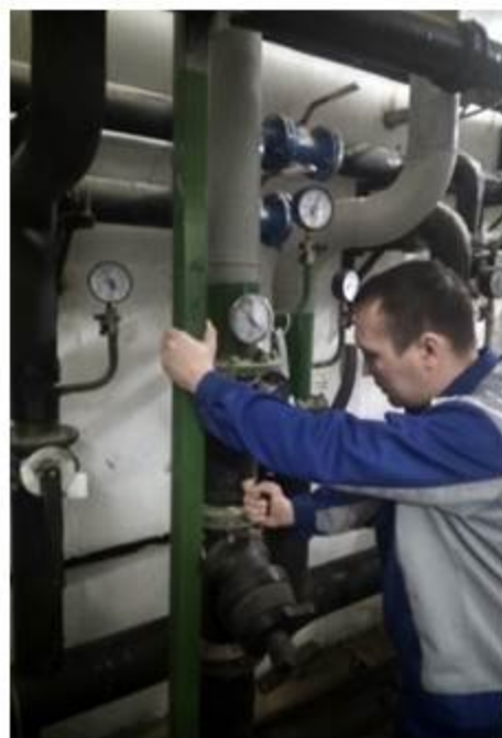
Регулировка балансировочных клапанов
