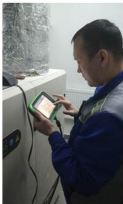
Настройка работы приточных установок
