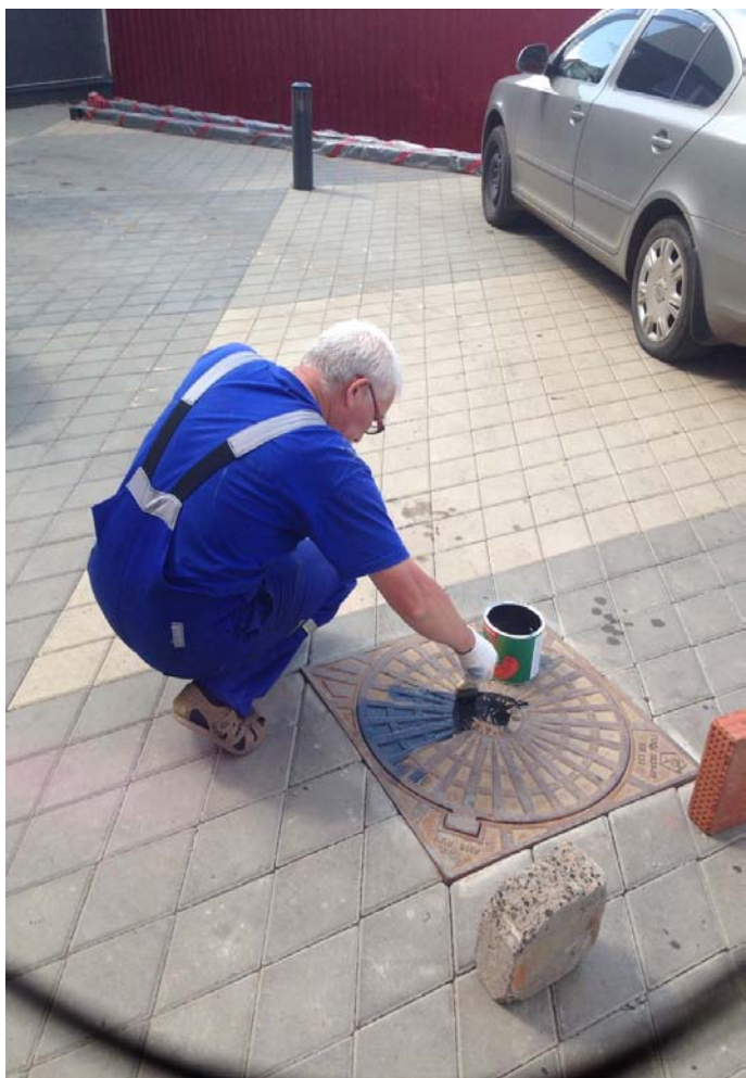
Покраска канализационного люка.
