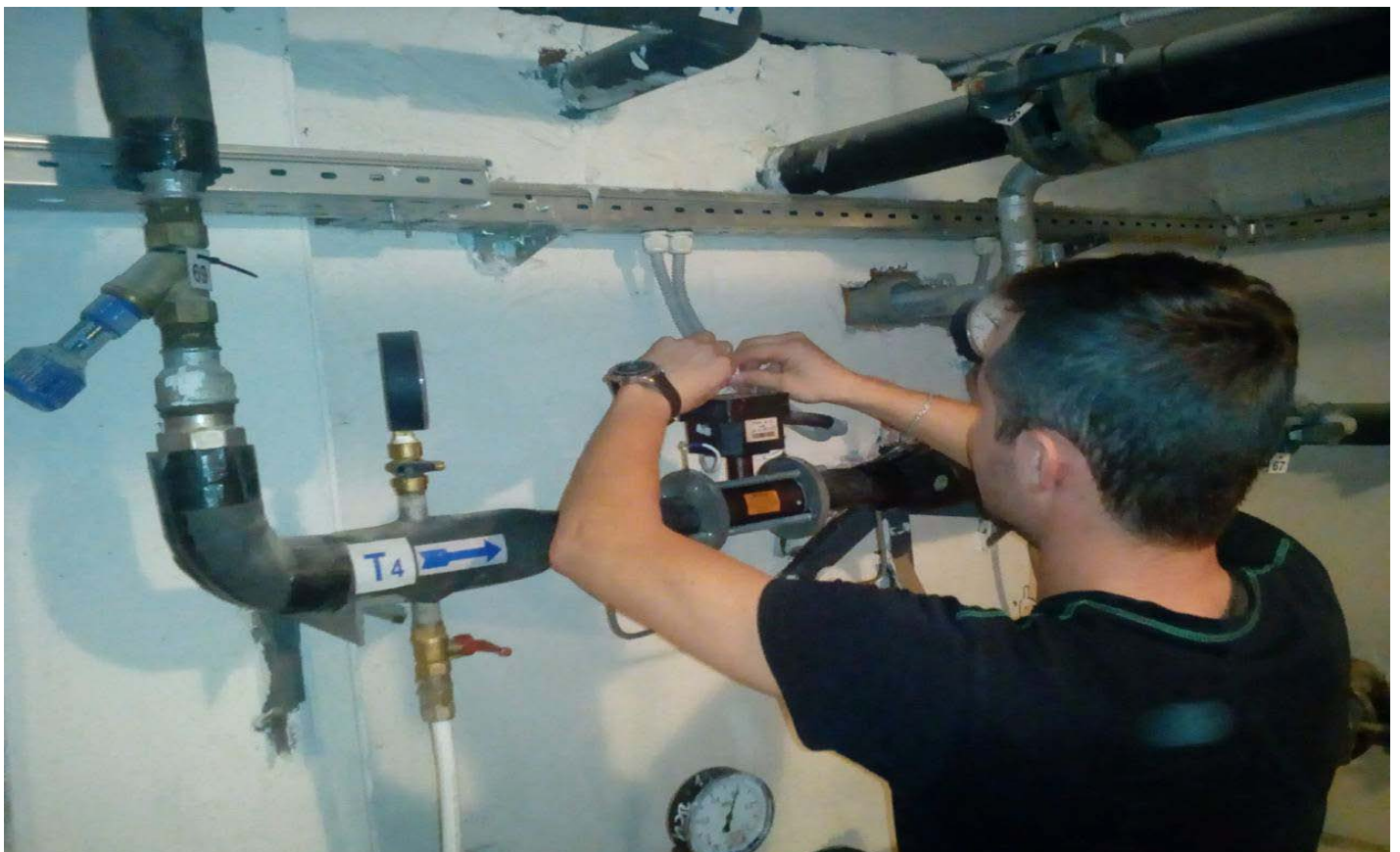
Обслуживание узла учета тепловой электроэнергии.
