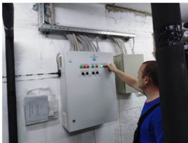
Отключение ГВС для гидравлических испытаний
