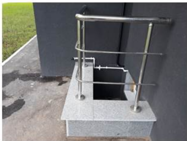
Монтаж трубы для полива газона
