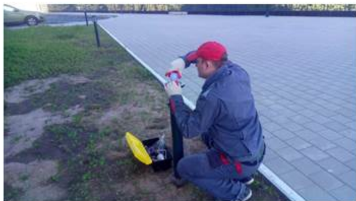
Замена ламп уличного освещения
