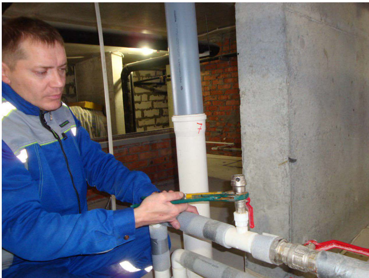
Установка спусковых клапанов.
