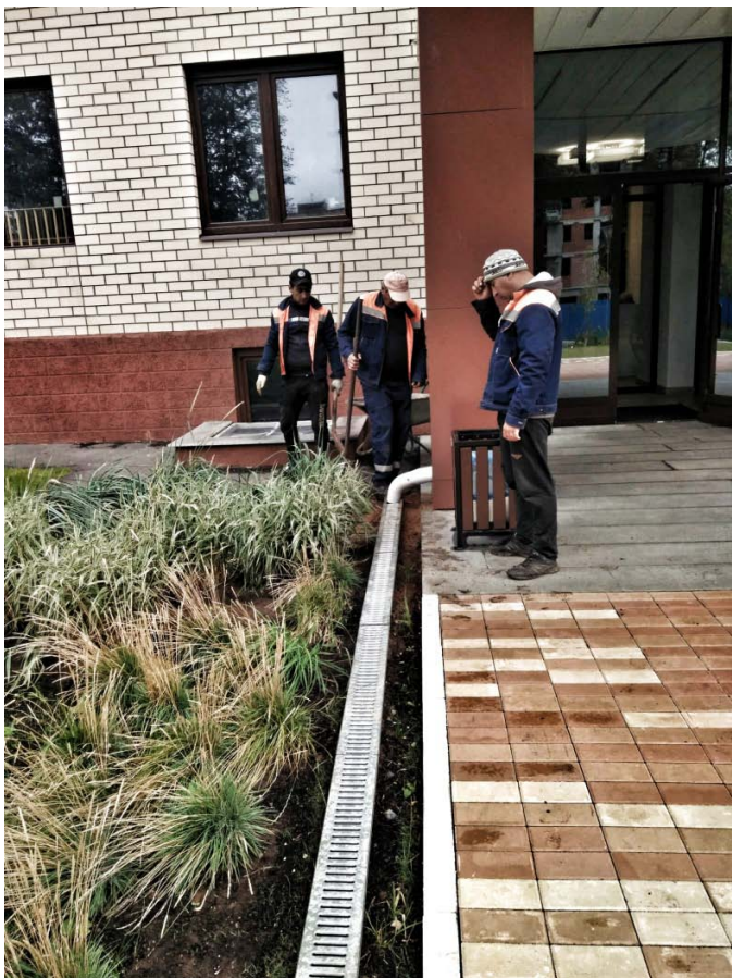
Восстановление ливневых лотков.
