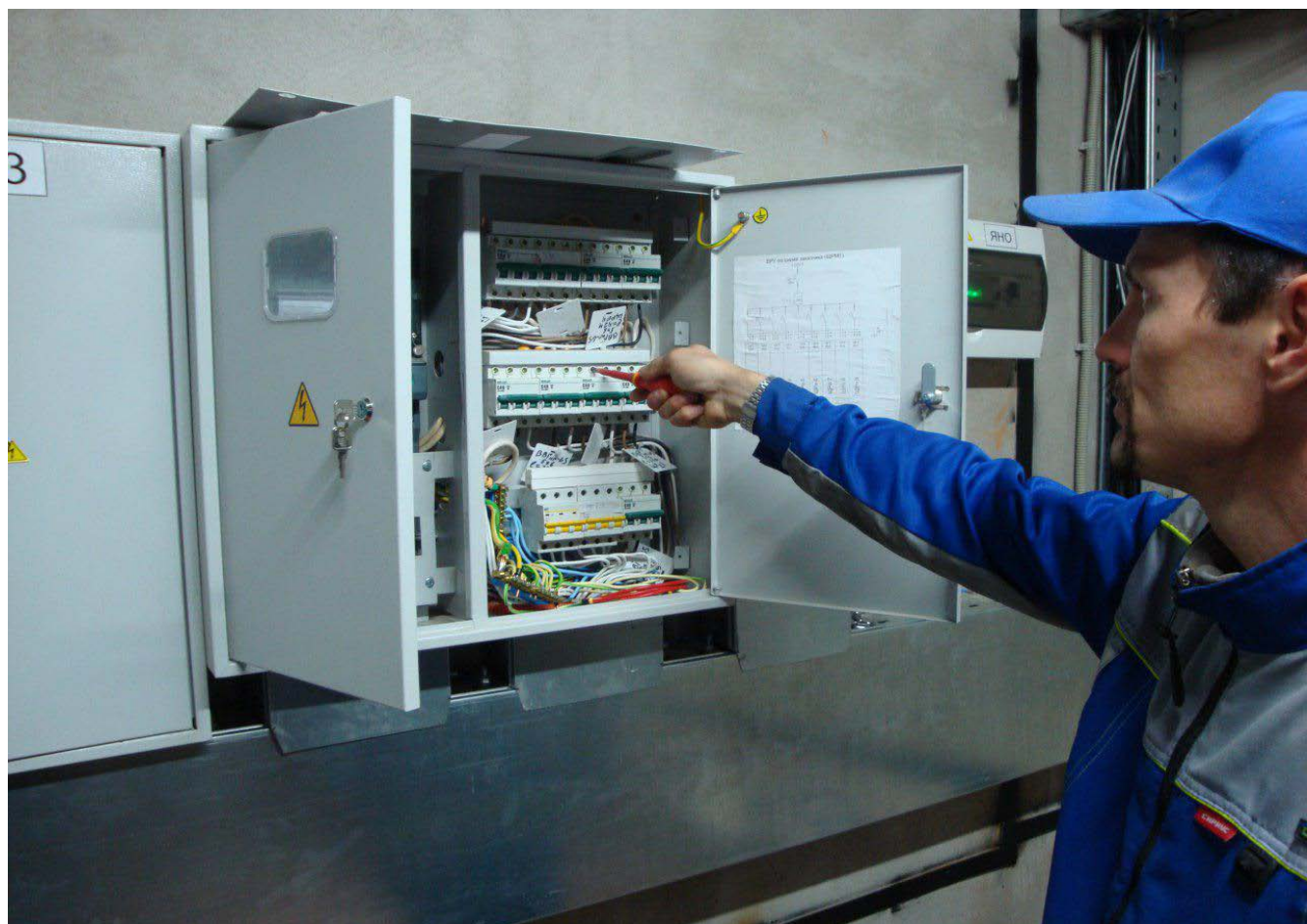
Протяжка винтовых соединений.
