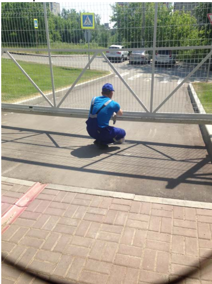
Покраска металлоконструкций.
