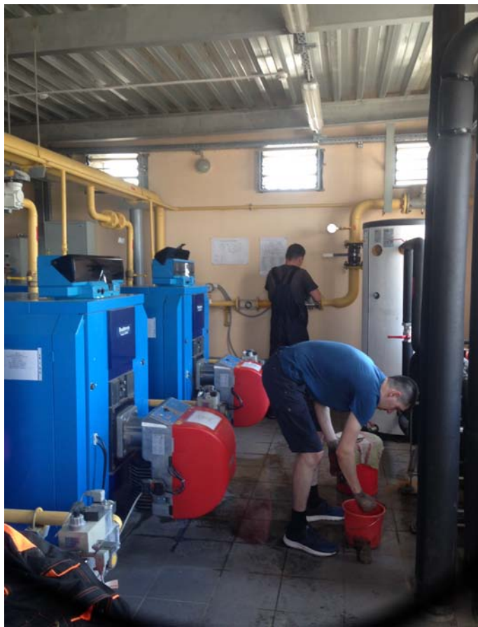
Техническое обслуживание котельной.
