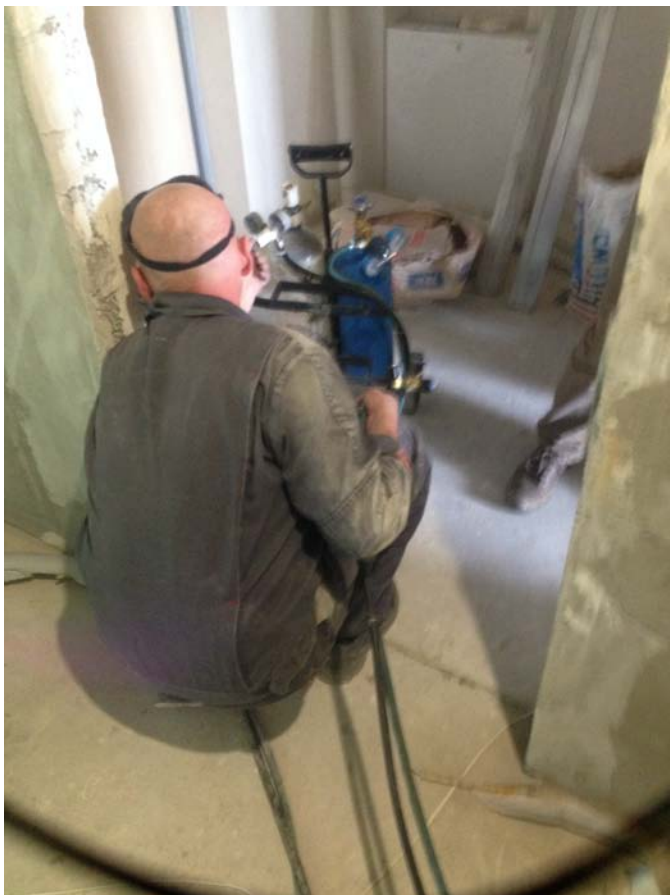
Ремонт стояков ГВС.
