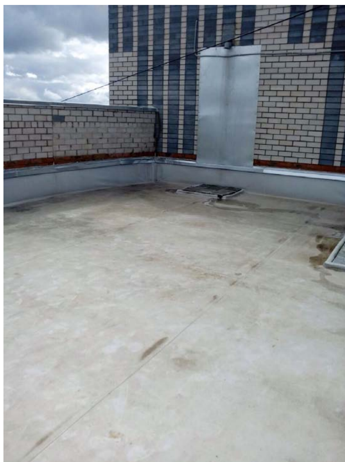
Уборка кровли от мусора.
