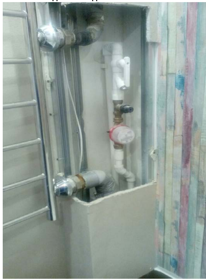
Ремонт полотенцесушителя.
